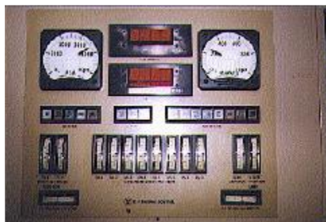
图 9-77: 典型的涡轮机控制面板
