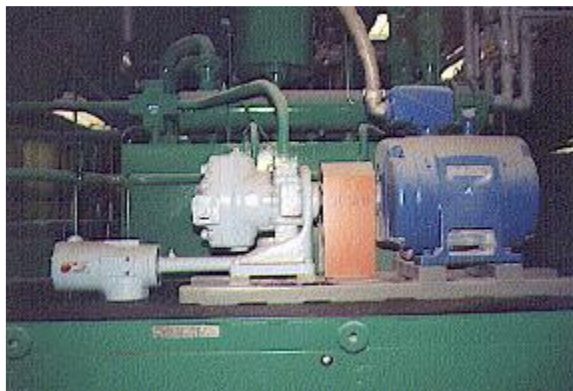
图 9-55: 典型的汽轮机液压油系统
