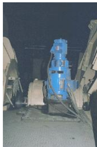
图 9-66: 涡轮盘车装置
