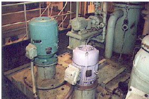
图 9-44：涡轮润滑油泵
